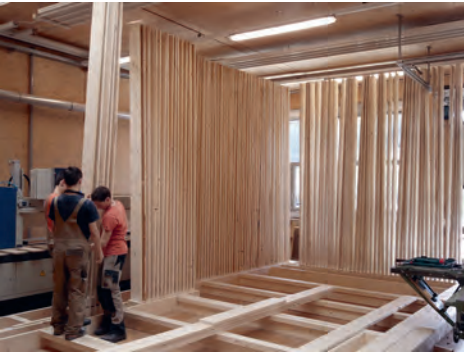
Schüler*innen der HTL Villach setzen den Entwurf in ihrer Holzwerkstätte um. Gemeinsam mit Studierenden montieren sie die vorgefertigten Elemente im Spittaler Stadtpark.
